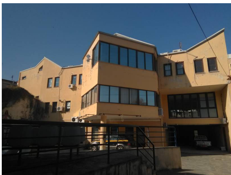
Εικόνα 2: Γενική άποψη του κτηρίου από τον ακάλυπτο
