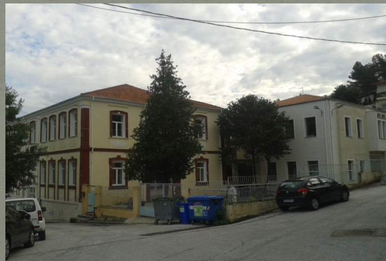
Το κτίριο μετά την 2 η προσθήκη
