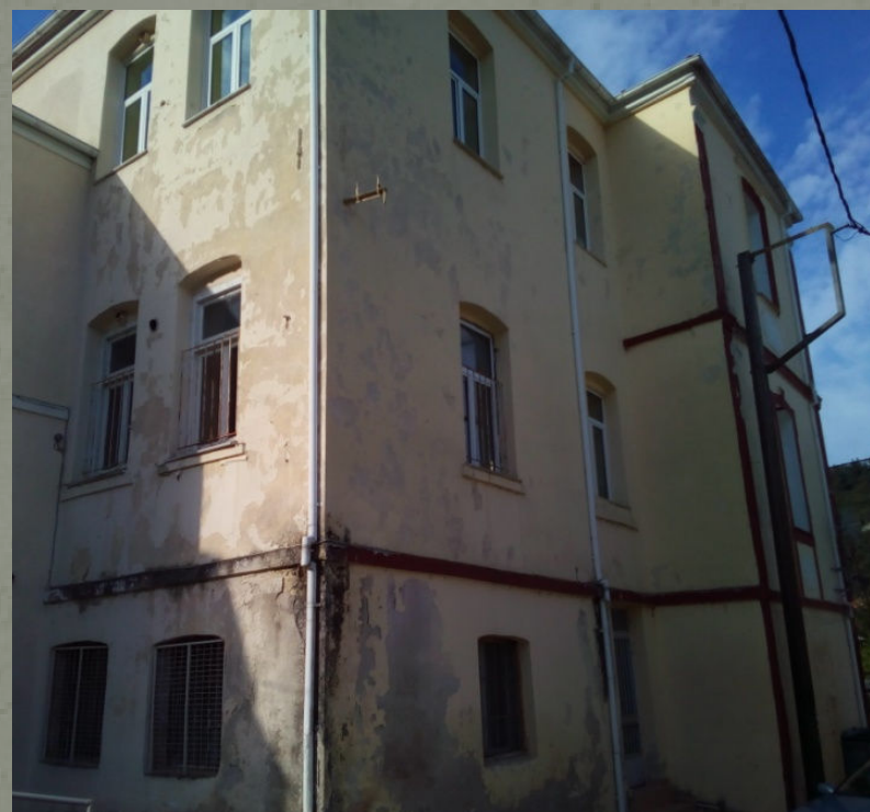
Απόψεις του κτιρίου με τις φθορές των επιχρισμάτων
