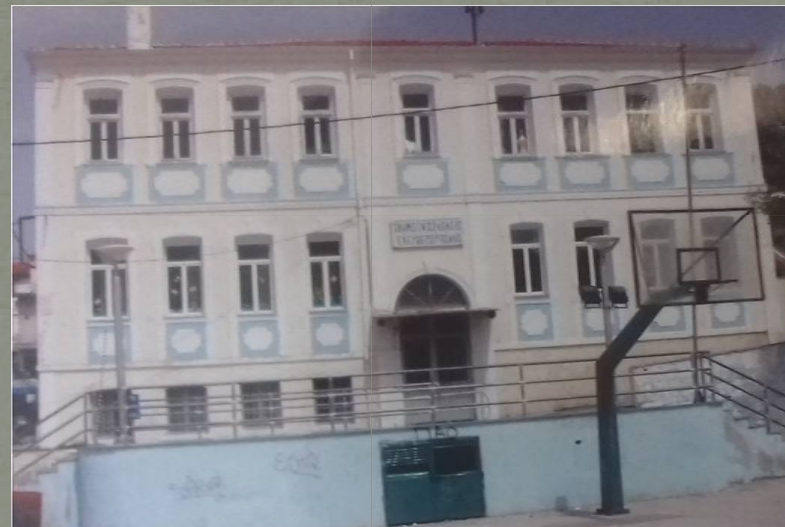
Το κτίριο μετά την 1 η προσθήκη
