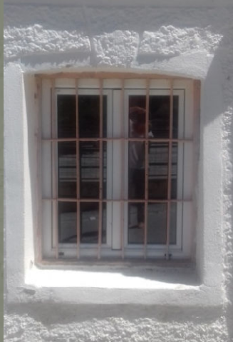
Παράθυρα Αρχικό κτίριο
